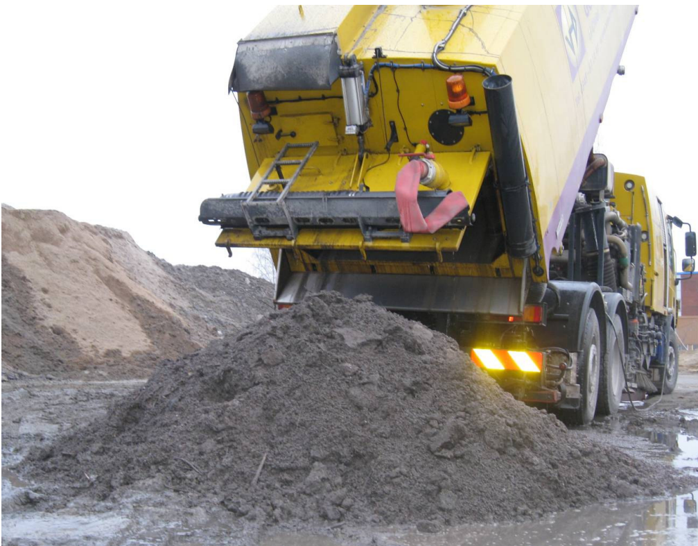
Figur 17. 5 ton uppsamlat vägdamm (Holländsk utrustning).
