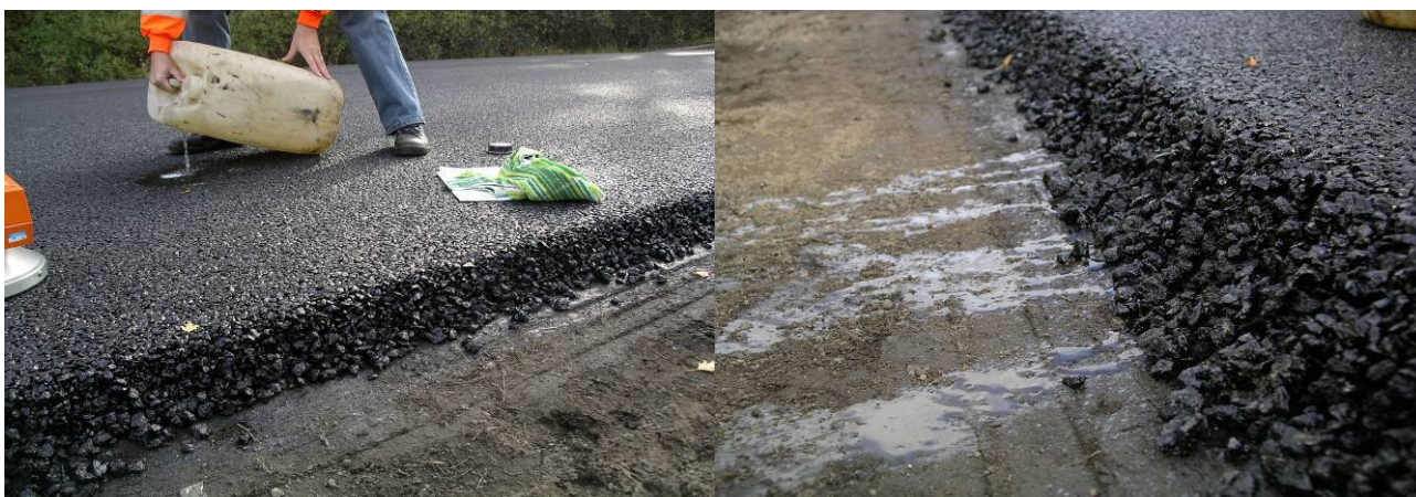
Figur 1. Öppen porstruktur med god dränerande egenskaper.
