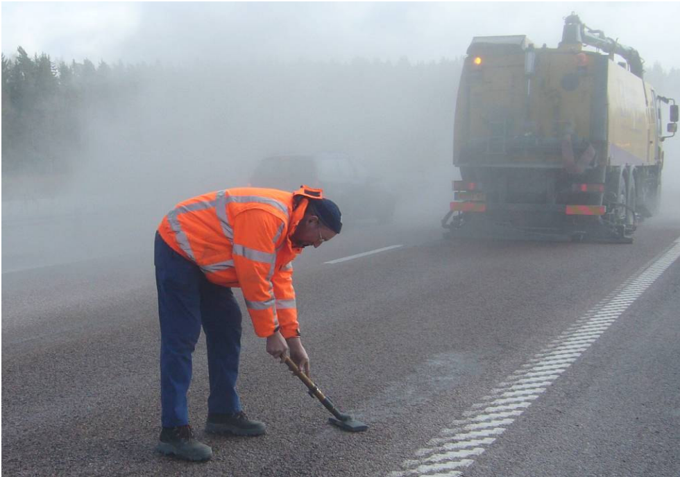
Figur 8. Högteknologisk rengöringsutrustning samt lite enklare utrustning för rengöring av öppna beläggningar.
