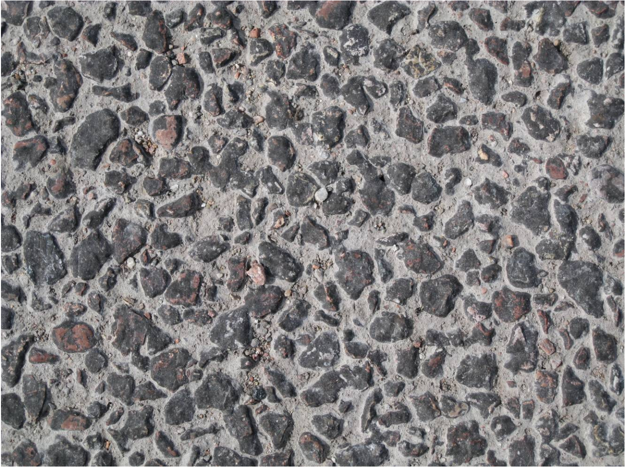
Figur 5. Förhållande Kraftigt igensatt beläggning, Väggen E18 Järvastaden, TA9.
