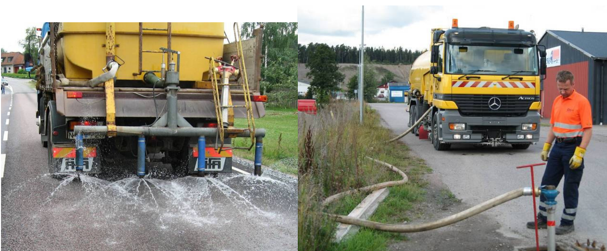
Figur 14. Förvattning av ytan samt påfyllninga av vatten.
